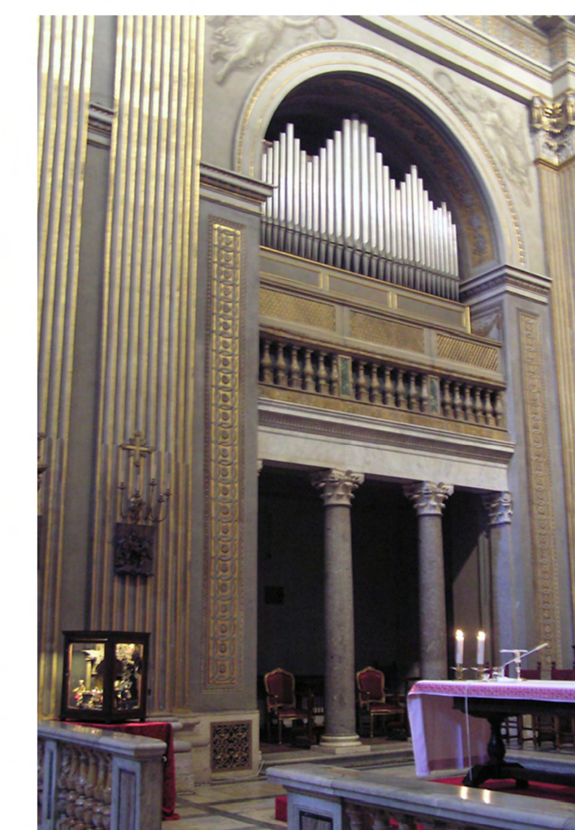
Intervención en el presbiterio de la iglesia de Montserrat, Roma
