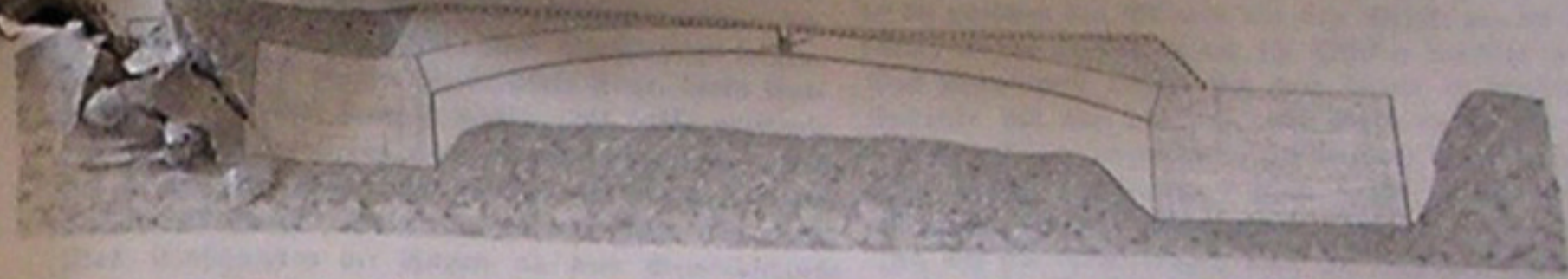
Fig. 2 Ansicht und Grundriß des Bogens, Schlussstein desselben auf ein Minimum der Stärke und Länge reduziert war.
