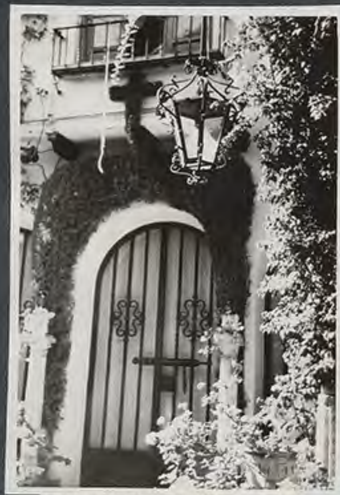
198 Córdoba, Patio de la Casa de Romero de Torres.
