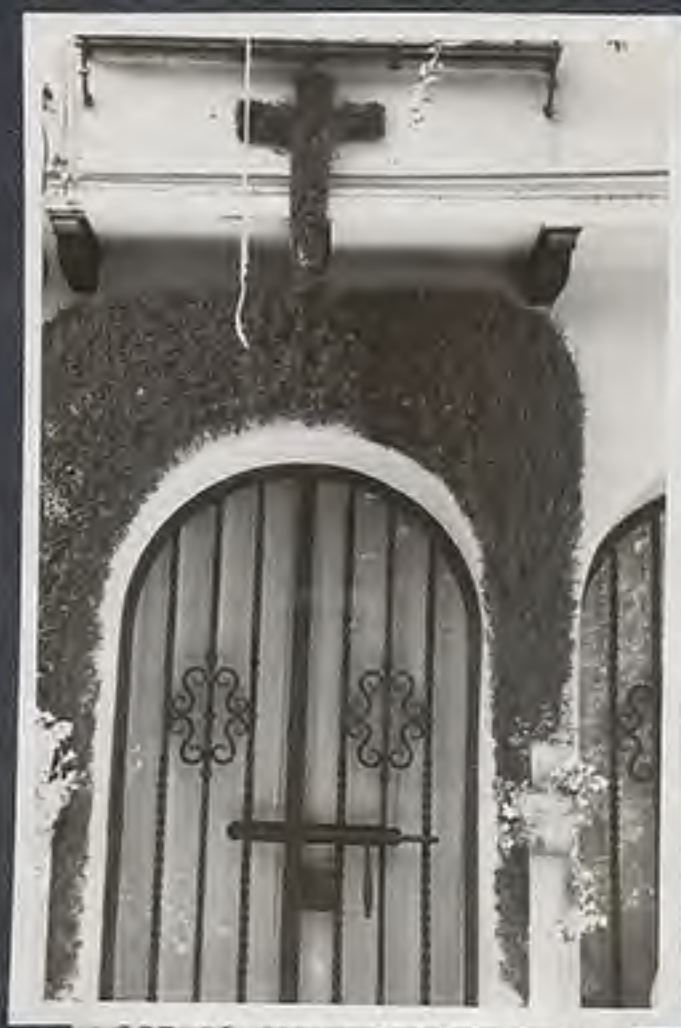
197 Córdoba, Patio de la casa de Romero de Torres
